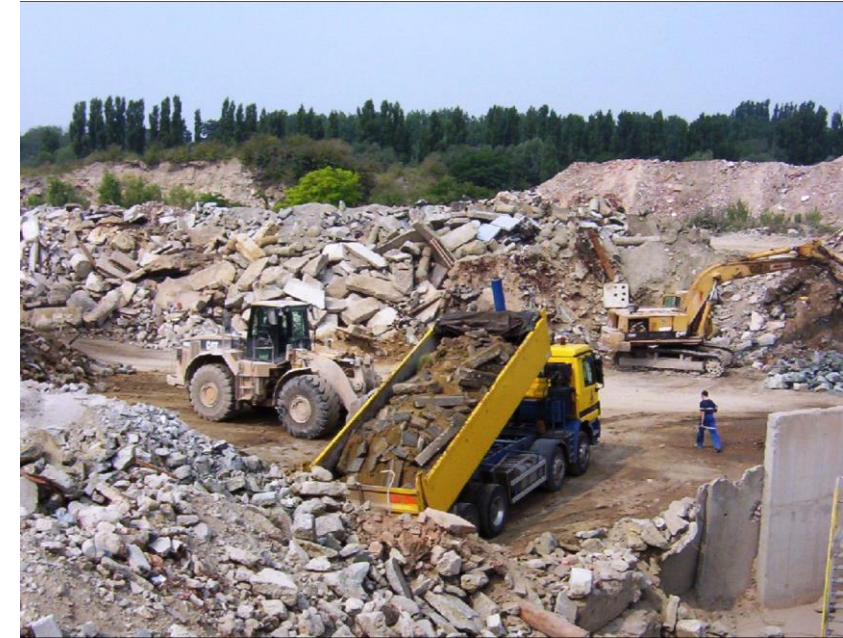
ΑΠΟΒΛΗΤΑ ΕΚΣΚΑΦΩΝ, ΚΑΤΕΔΑΦΙΣΕΩΝ & ΚΑΤΑΣΚΕΥΩΝ
